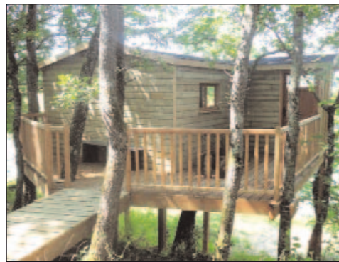
Les hébergements insolites «une cabane dans les arbres et une roulotte» de Christian et France Lafforgue à Pouylebon.
