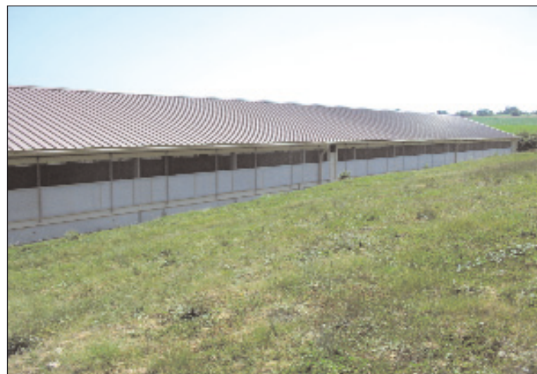
Une butte a été renforcée au Nord du bâtiment afin d'atténuer les sons engendrés par l'élevage.
