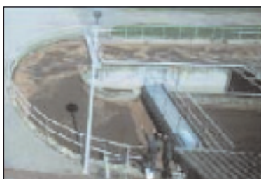
Traitement biologique du lisier (Source : IFIP)
