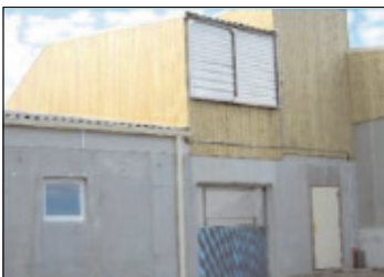
Echangeur de chaleur (Source : IFIP)
