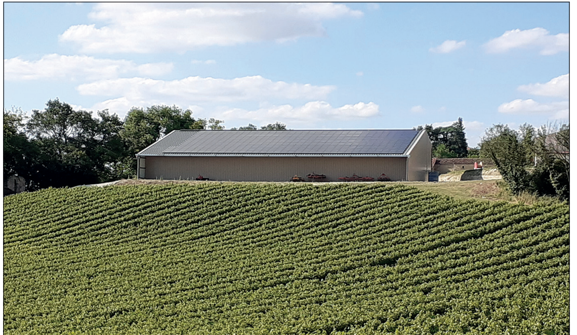
L'équipement photovoltaïque du bâti technique agricole facilité
